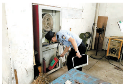
工作人员对重点区域开展巡查。
